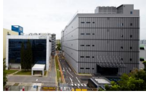
Keppel DC Singapore 2* & 3** & 4**
